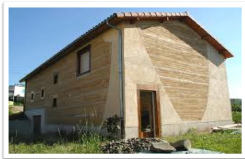
Figure 1.4 : Construction d'une maison en pisé
