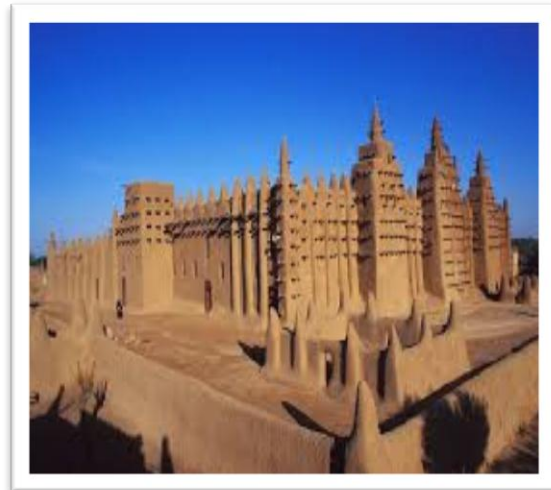
Figure 1.2 : Mur en adobe
