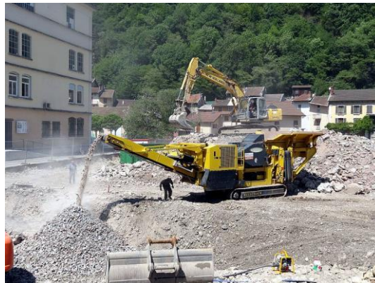
Figure 1. 5 Concassage des déchets de démolition.
