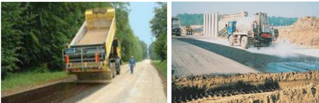
**Figure II.21** : Protection de surface de la couche traitée. [52]
