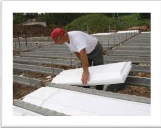
*Figure II.5 : La facilité d'installation del'hourdis polystyrène [2].*
