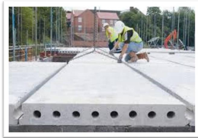
*Figure II.7:* Le placement de l'hourdis précontraint [3].
