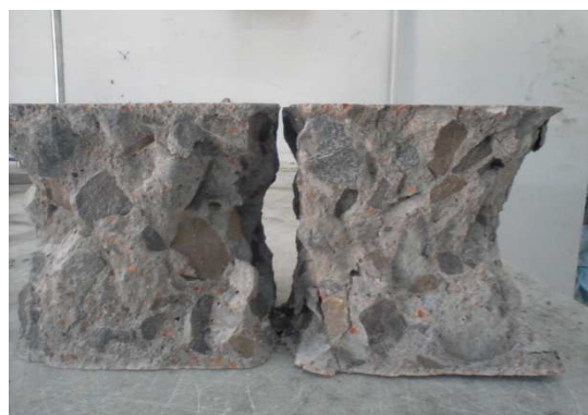
Photo III-4:Exemple de rupture
