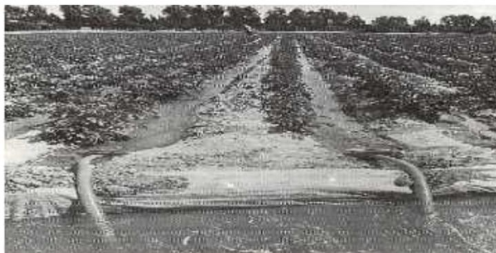
**Figure 2 : Irrigation par sillons (Booher, 1974).**
