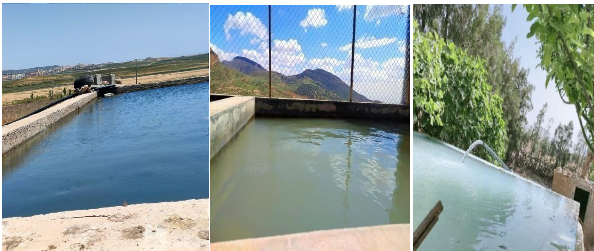
Figure 10 : Bassin alimenté par un forage (Originale ,2022).
