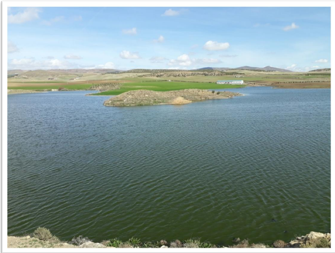
Vue d'ensemble de la zone humide coté sud (06/03/2017)
