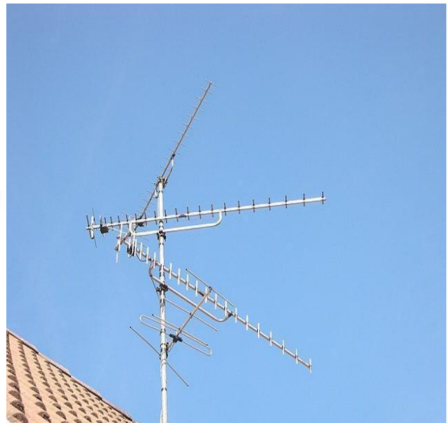
Figure.I.021:Constitution d'une antenne Yagi
