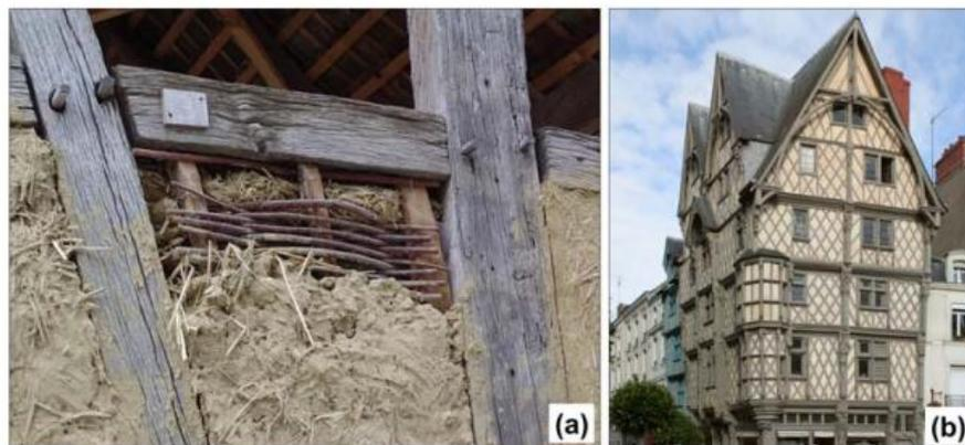
**Figure 1.2.** (a) La technique du torchis ; (b) Une construction en torchis à Angers, France. [8]
