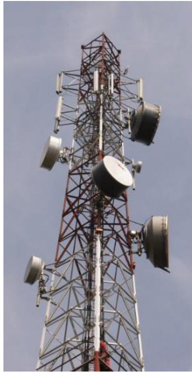
Figure. I-2. Pylône de télécommunication
