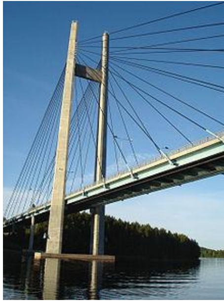
Figure. I-3. Pylône pour ponts
