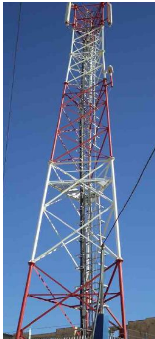
Figure. I-7. Pylône auto stable (de section triangulaire)
