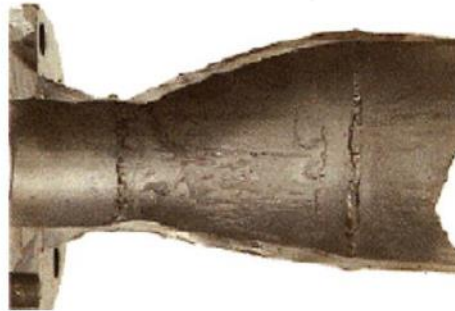
Figure I.9 : Corrosion-érosion dans une zone turbulente.
