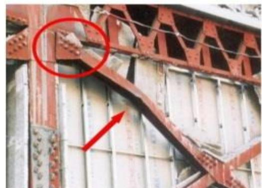
**Figure II.5 :** Flambement des barres en X.
