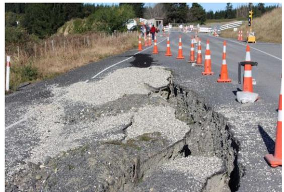
Figure I.8: Remblai routier à cause de liquéfaction du sol.
