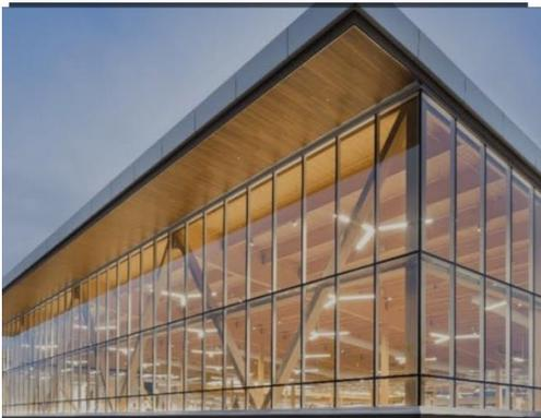
**Figure III.1 :** Une Structure mixte Bois-Acier
