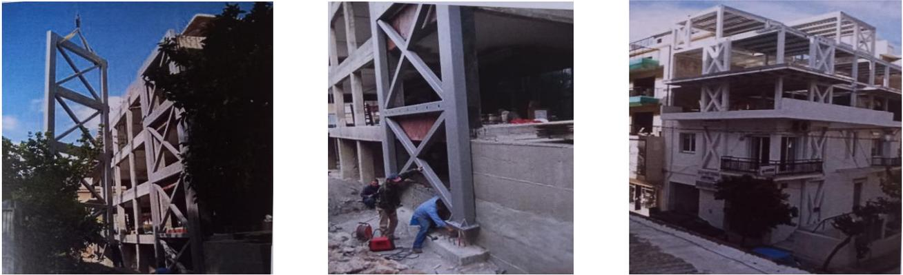
**Figure II.7 :** Confortement/ renforcement des bâtiments avec des panneaux paradant
