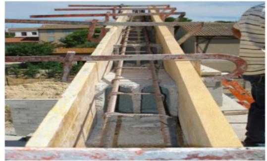
Figure I.18 : Mise en place d'un chaînage au niveau du rampart d'un bâtiment.
