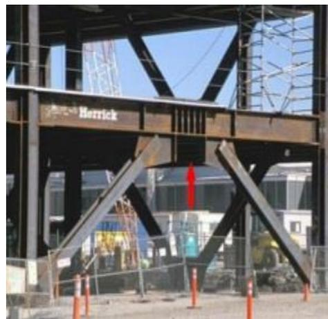
**Figure II.14:** Bâtiments avec des contreventements excentrés.
