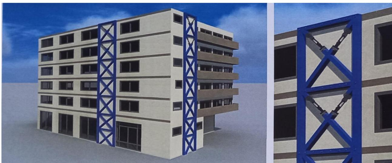
**Figure II.6 :** Confortement/renforcement des bâtiments existants.
