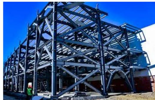
**Figure II.10:** Structures métalliques contreventées par des palées de stabilité en X
