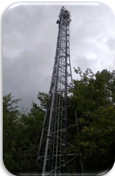
Fig I.77: Pylônes à trois pieds
