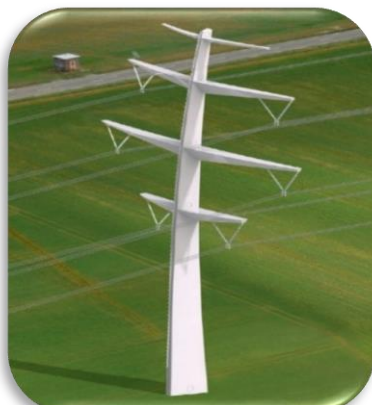
Fig I.12: Pylône électrique Muget
