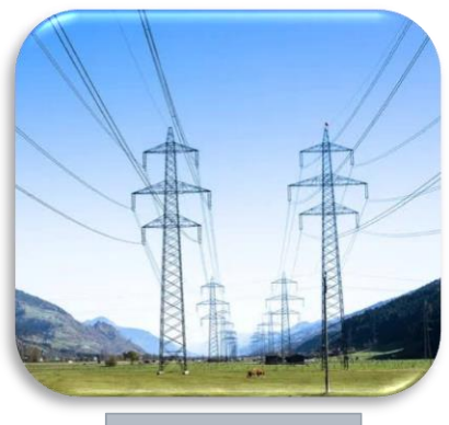
Fig I.8 : Pylône à six triangles
