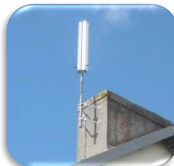
Fig I.41: Antenne à fente
