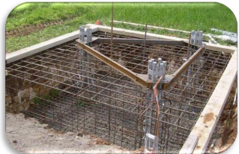
Fig I.68: La fondation superficielle
