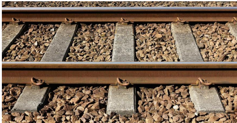
Figure I. 9: Agrégats dans le ballast ferroviaire
