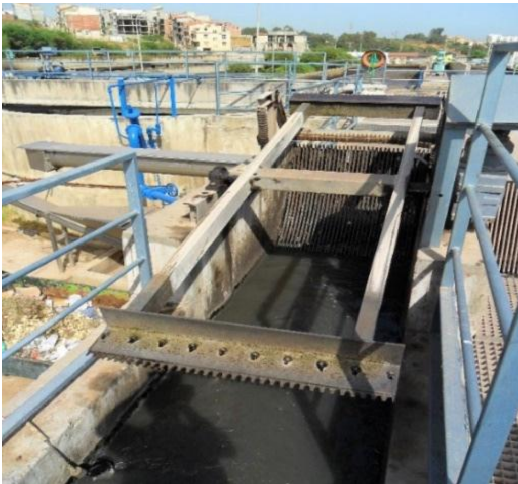
Figure I. 3 : Dégrillage
