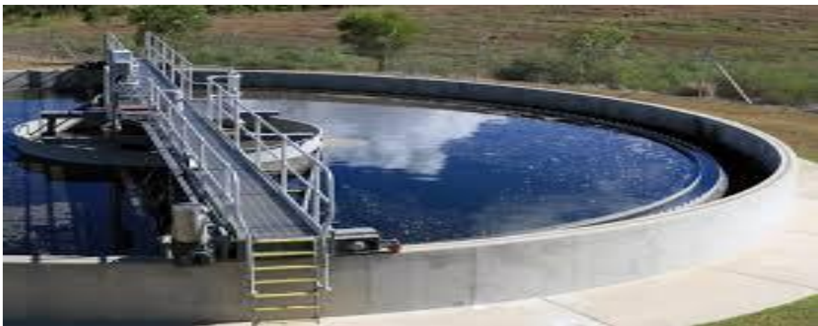
Figure I.8 : Récupération des eaux épurées du clarificateur par surverse.
