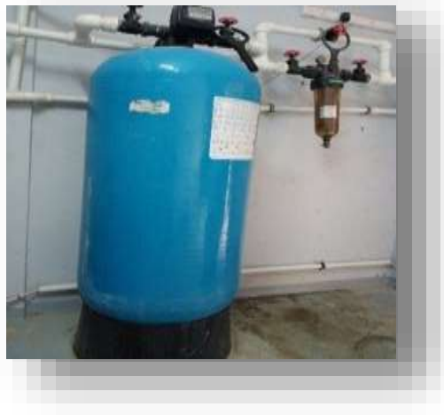
Figure. 20. Filtre à sable.
