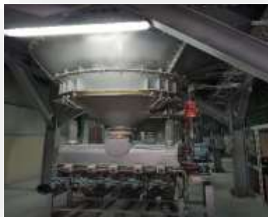
Figure. 7. Silo de la matière première
