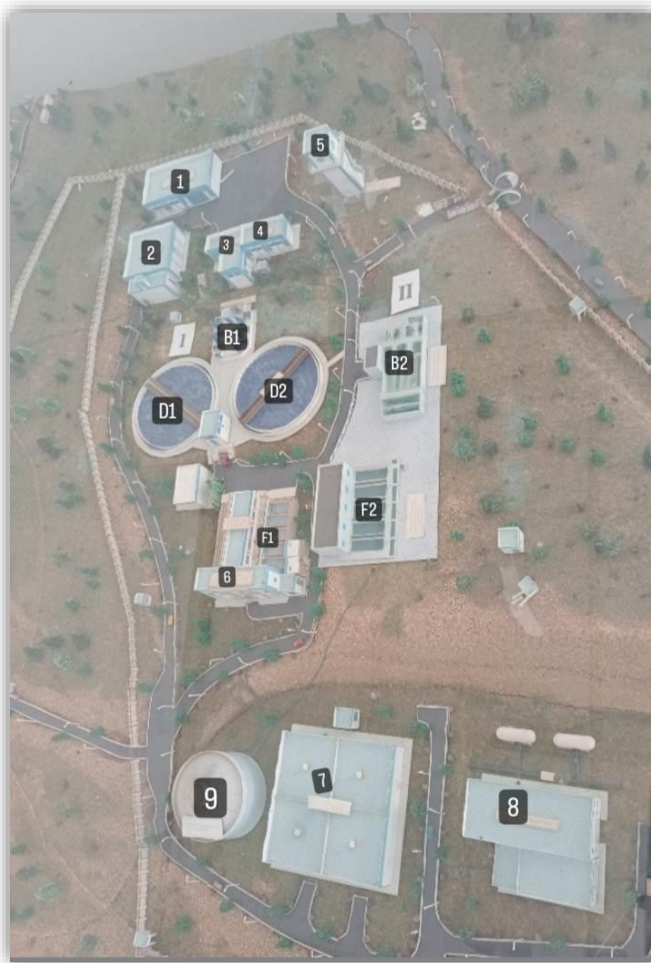
Figure II-2 : la station de traitement
