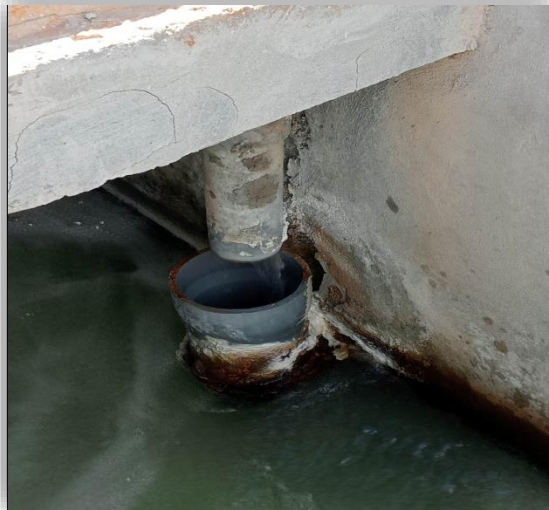
Figure II-4 : Injection de sulfate d'aluminium
