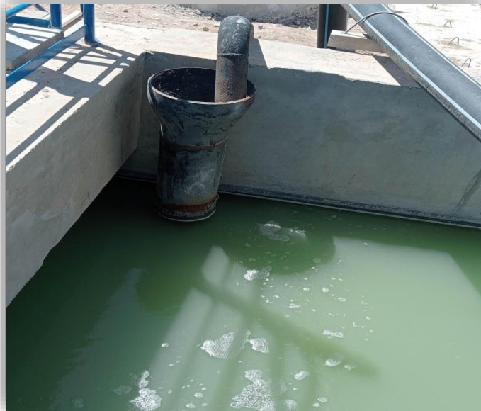
Figure II-5 : Injection de polymère
