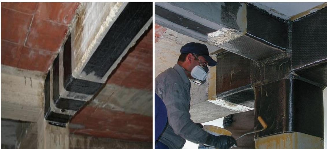
**Figure 15 : Renforcement par matériaux composites**
