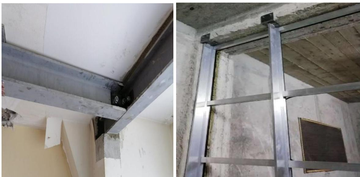
**Figure 14 : Renforcement par ajout d'armatures extérieures**
