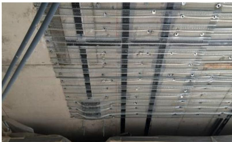
**Figure 17 : Renforcement par post- tension**
