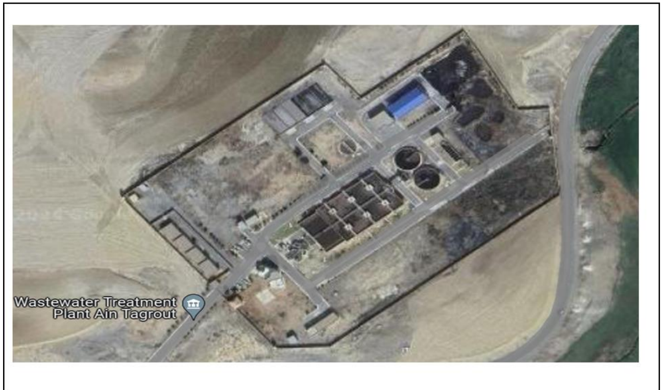
Figure III.2 : Station d'épuration des eaux usées de Commune de Ain Taghrouit.
