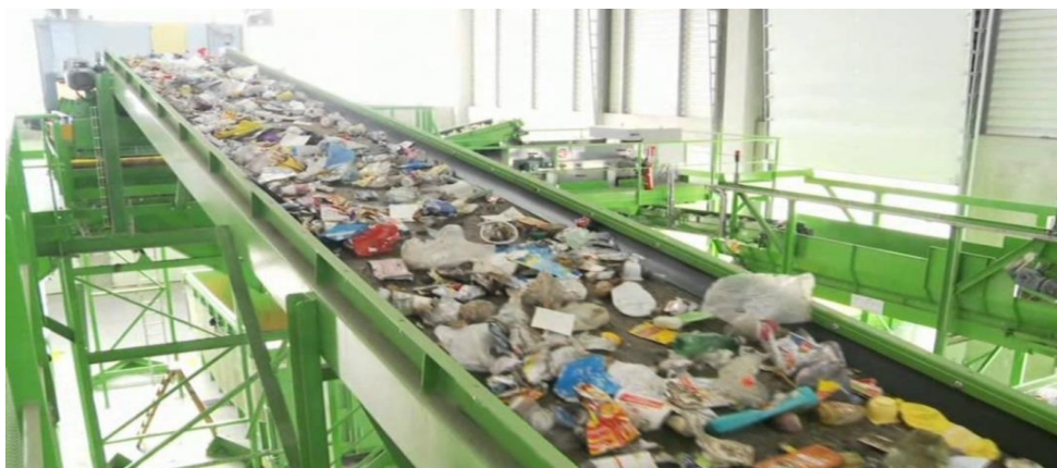
Figure III.4 : Tapis roulant dans un centre de tri des déchets ménagers
