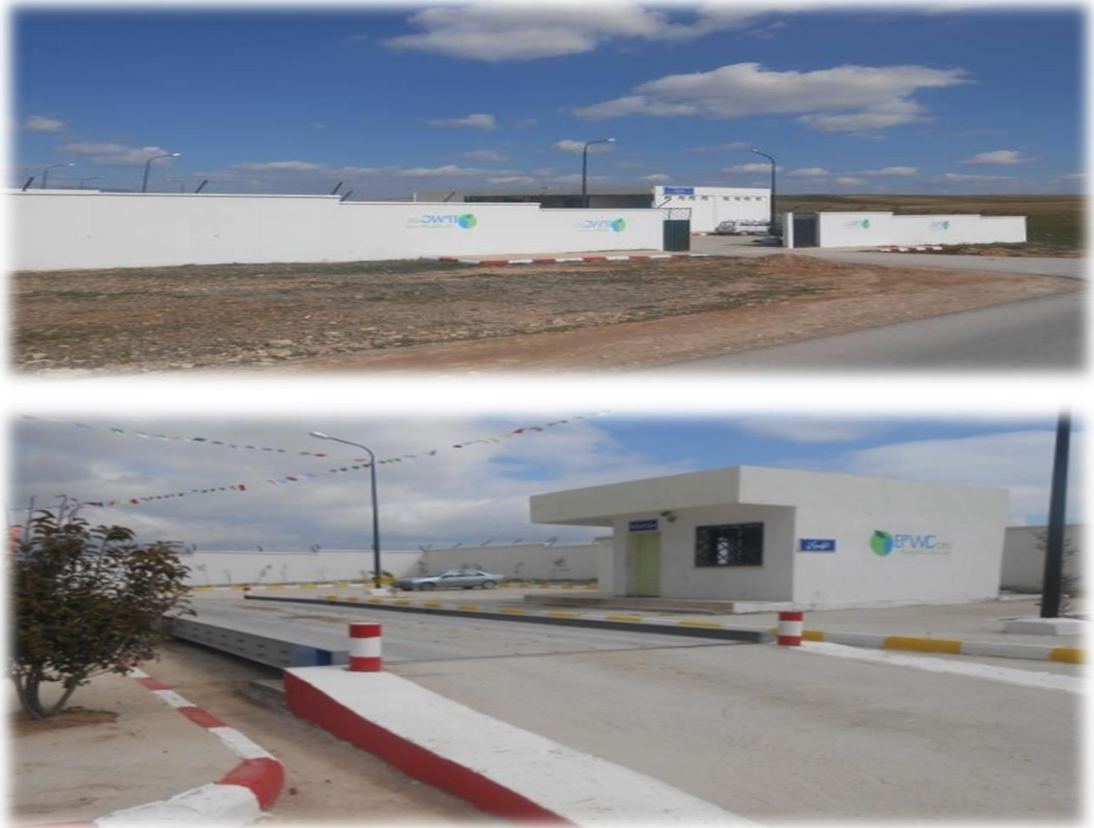
Figure II.3 : Centre d'Enfouissement Technique (CET) à la commune de KHELIL
