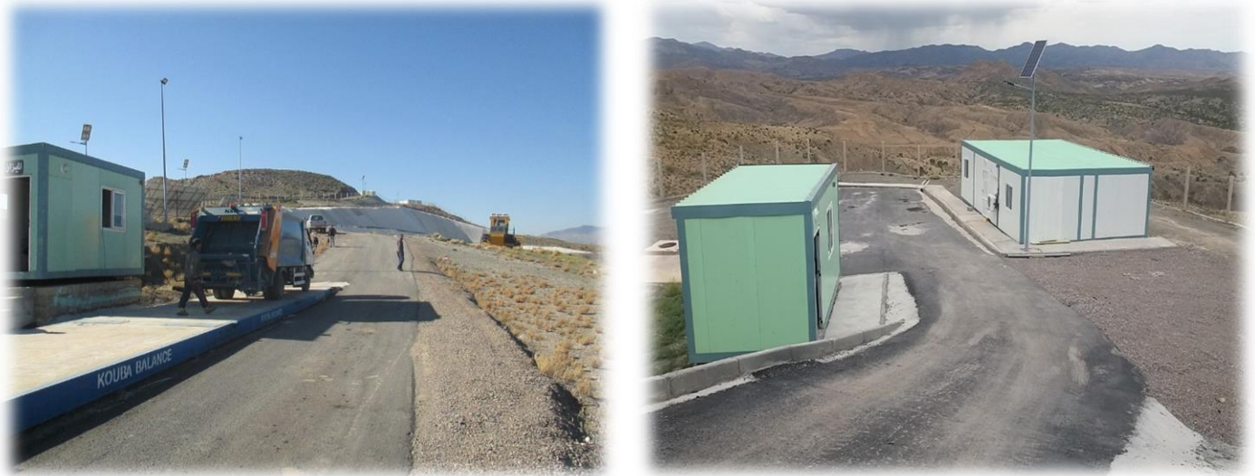
Figure II.4 : Centre d’Enfouissement Technique (CET) à la commune de MANSOURAH.
