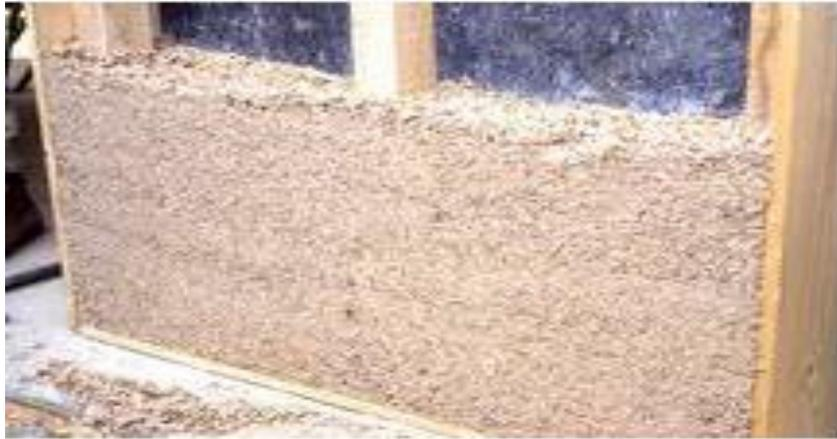
*Figure I. 6 Procédé de mise en œuvre par banchage*
