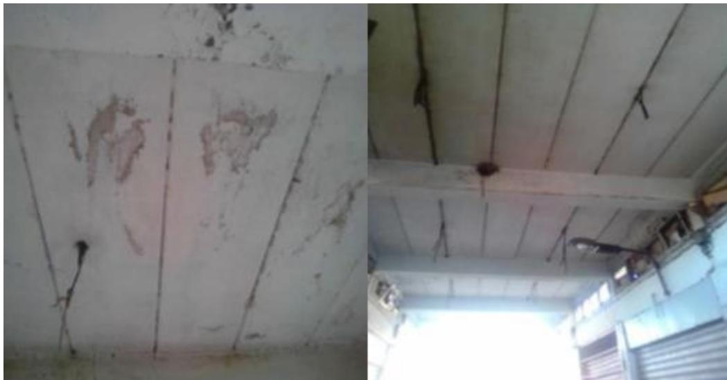
*Figure I. 27 Dalles en béton cellulaire photos agrandies [31].*
