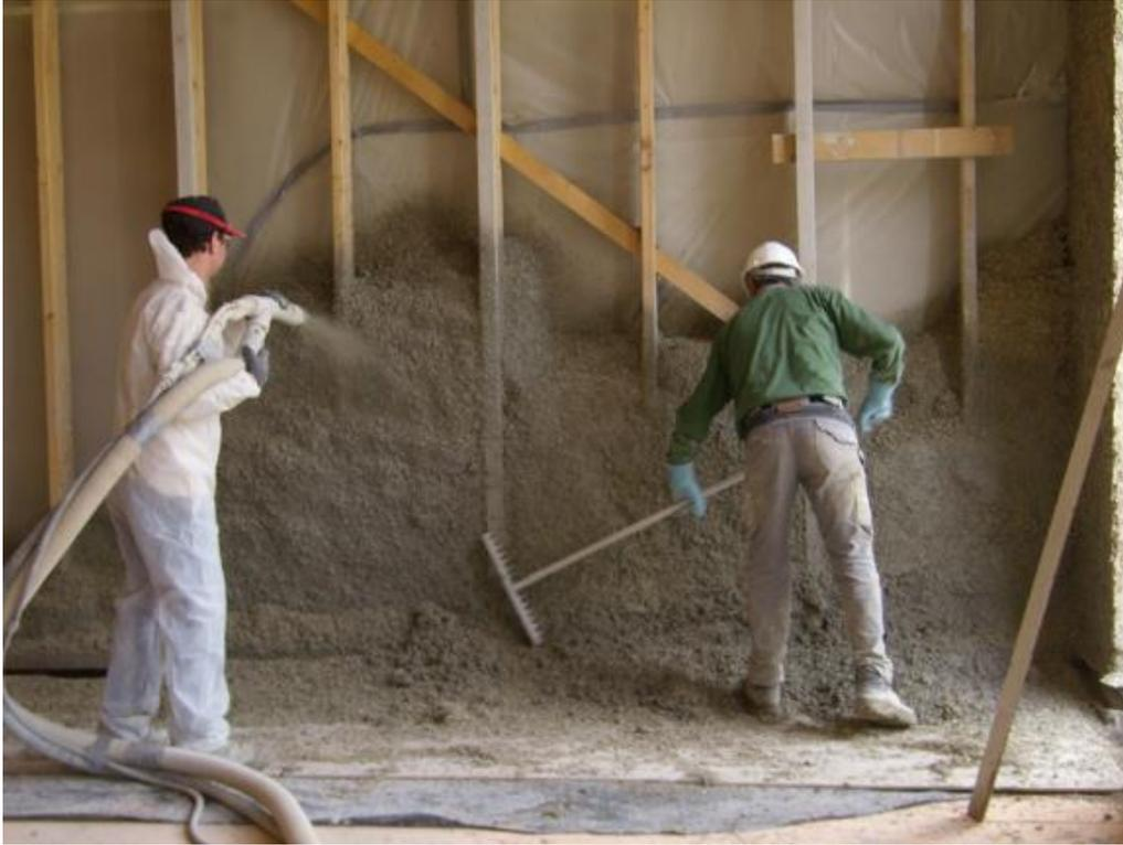
*Figure I. 7 Procède de mise en œuvre par projection*
