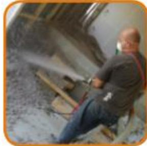
*Figure I. 41 La ouate de cellulose en vrac peut être appliquée en voie sèche ou en voie humide*
