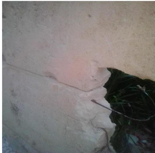
*Figure I. 25 Béton cellulaire armé.*
