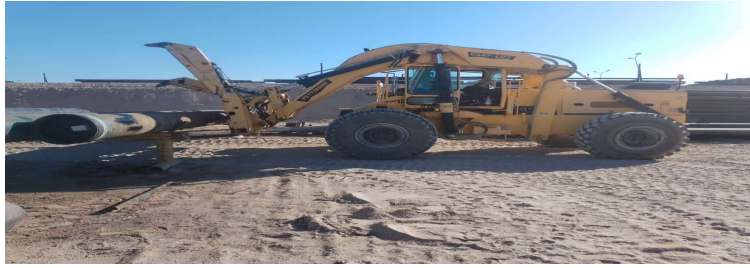
Figure. 31. Déplacement de tubage
