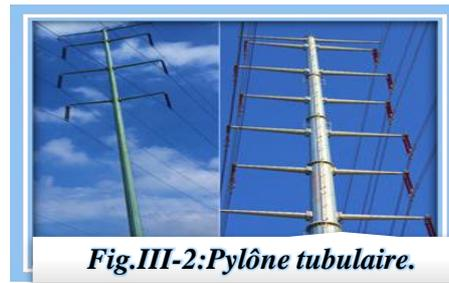
**Fig.III-2: Pylône tubulaire.**
