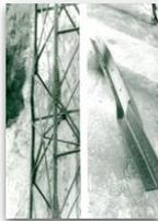
*Fig.III-10: Vue de la rupture et des barres flambées de pylône*
