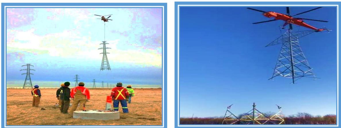
*Fig.III-23 : Montage des tronçons de pylône à l'aide d'un hélicoptère.*
