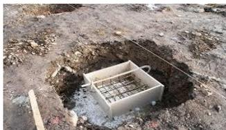
l'embase. Une fois que la prise du béton de la semelle a été faite on passe à la réalisation du coffrage pour la cheminée
