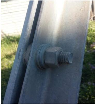
Les pièces de pylônes viennent en lots de barres de même dimension et des boulons de dimensions différentes pendant la phase de colisage il faut reconstituer tous les pylônes puis ils sont transportés jusqu'aux différents lieux d'implantation où ils sont assemblés. Une fois l'assemblage terminé il faut vérifier que tous les boulons ont été correctement serrés et
