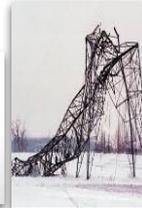
*Fig.III-13: Ruine d'un pylône sous le poids de la glace accumulé sur les lignes de transmission.*
