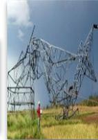
*Fig.III-11: Pylônes complètement tondus suite à la plastification totale de ses éléments causée par une tempête .*
