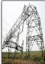
*Fig.III-12: Un pylône électrique endommagé par une grande plastification /flambement à cause d'un tempête -ruine.*
