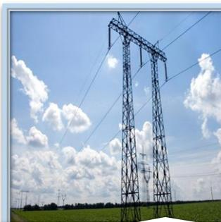
**Fig I-3: Pylône électrique portique.**
