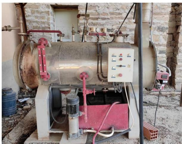
**Figure 3- Vapeur d'eau produite par une chaudière (Photographiée Originale)**
