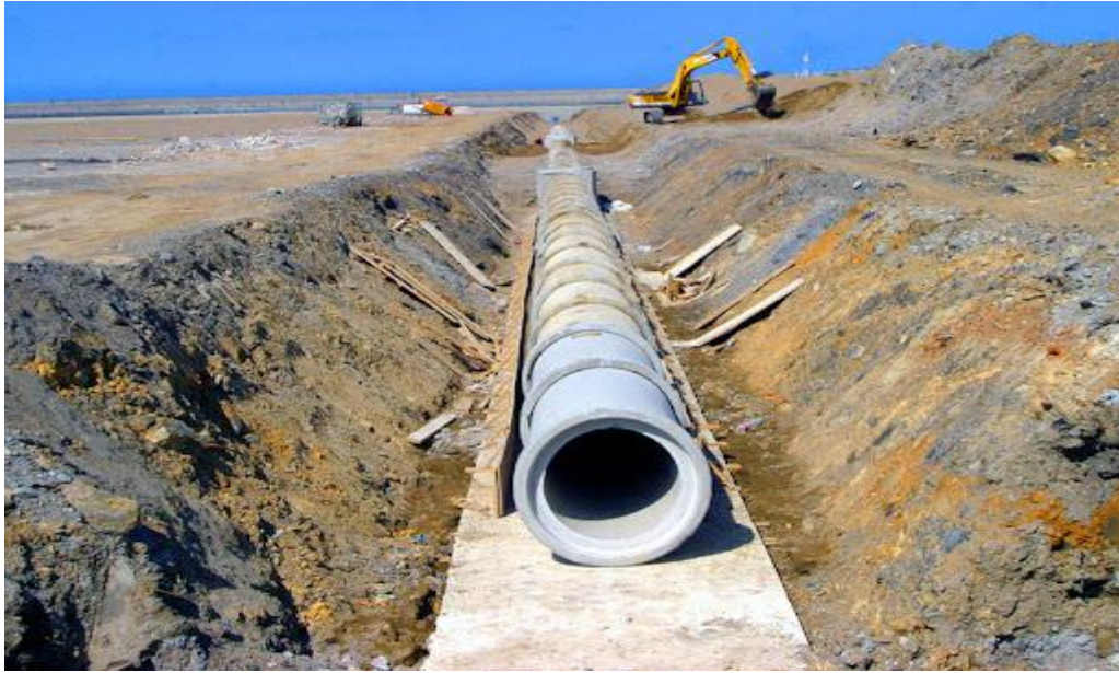
Figure I.3- Méthode de pose d'un canal de 1500 mm destiné à l'écoulement des eaux d'Oued
