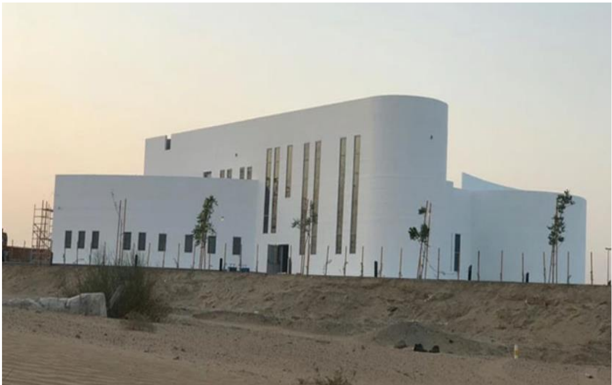
Figure 10 Le plus grand ouvrage imprimé au monde construit par l'entreprise Apis Cor.
