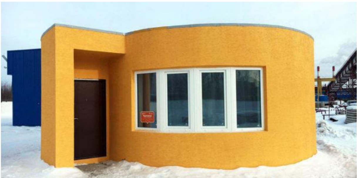
Figure 9 : Habitat imprimé par l'entreprise Apis Cor en Russie. En haut pendant le chantier, en bas lors de la livraison.
