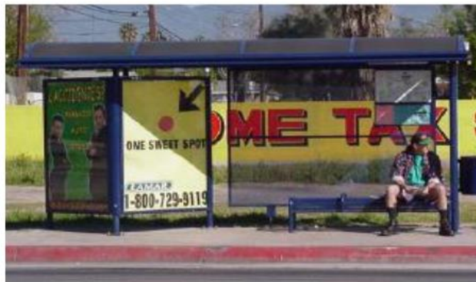
Figure II-9 Arrêt de Bus Ordinaire avec Aménagements Minimalistes.
