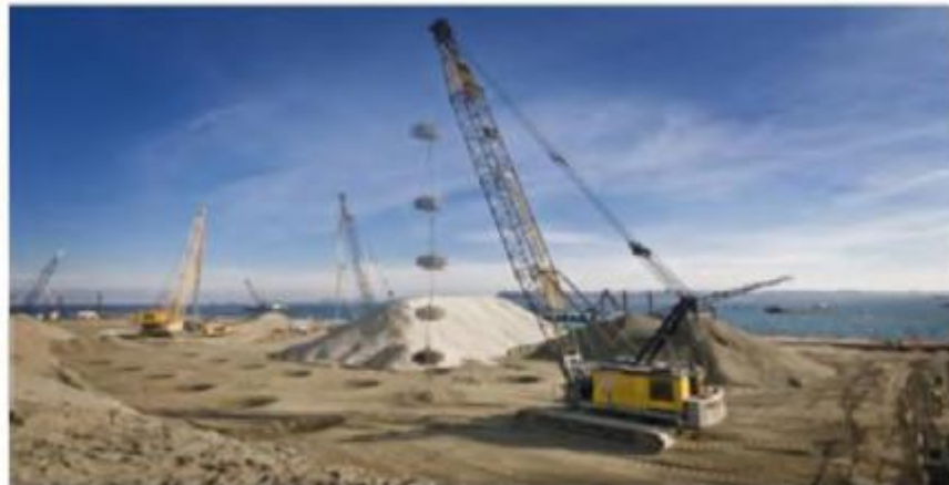
Figure II.9. chantier d'un compactage dynamique profond. [12]
