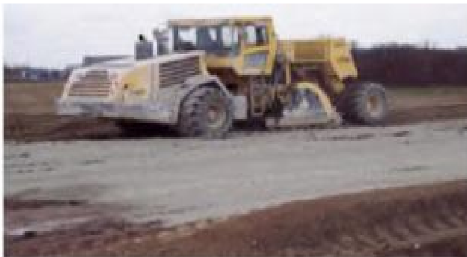
Figure II.16: Chantier de traitement du sol au ciment. [13]
