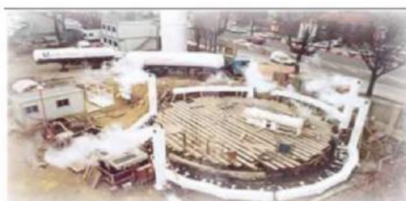
Figure II.11. Chantier utilisant la congélation du sol. [12]
