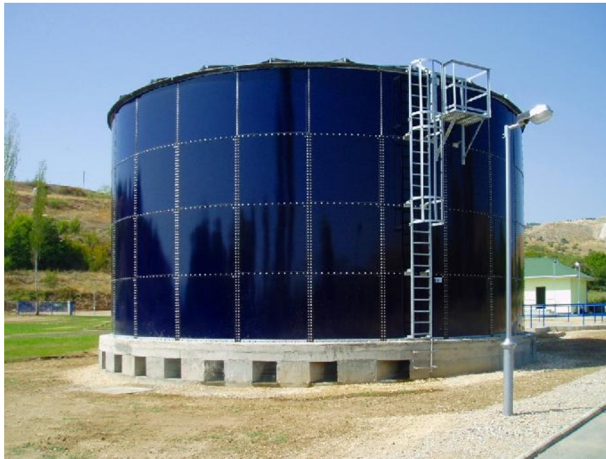
Fig. III.9: Exemple d'un réservoir de stockage d'eau
