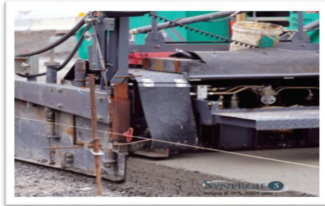
Figure 6: couche de BCR à la sortie du finisseur
