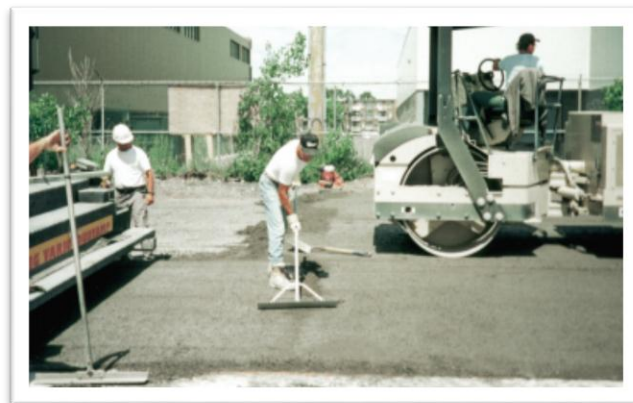
Figure 7: Répartition à l'aide de raclettes.
