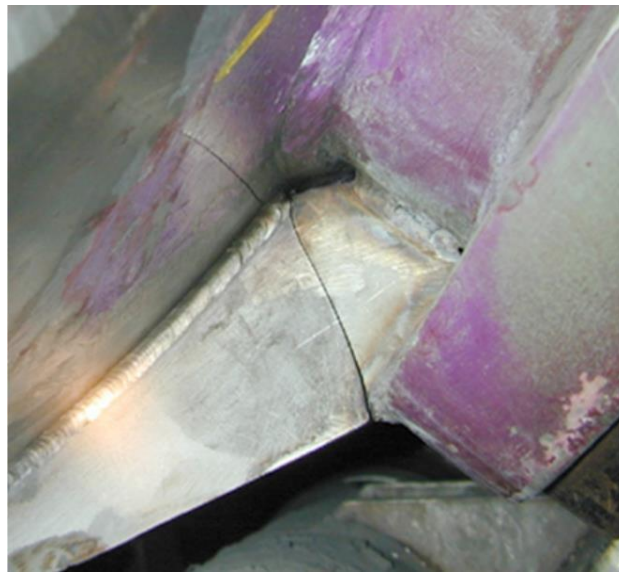
Figure I. 11: Exemple de fissure détectée sur une plaque de renfort d'un carter de générateur [7].
