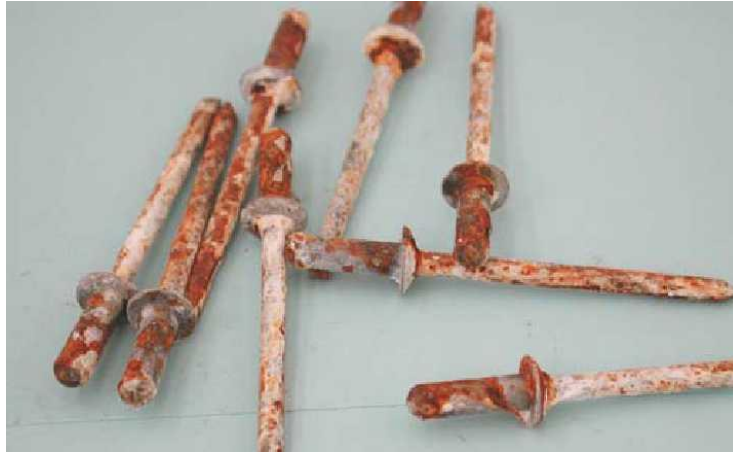
Figure I.1. : Une Corrosion Chimique
