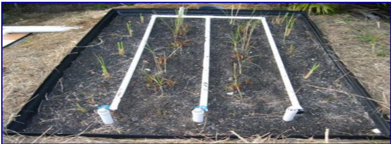
FIGURE 11: DISTRIBUTION DES EAUX USEES DANS LES STATIONS D'EPURATION A FLUX VERTICAL (VF) A BEXHILL, NOUVELLE-GALLES DU SUD, AUSTRALIE.
