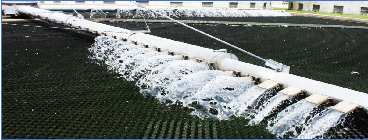
FIGURE 3: SELECTION ET FOURNITURE D'APPAREILS D'ECLAIRAGE PRIMAIRE ET DE SECOURS POUR STATIONS D'EPURATION DE NOUVELLE GENERATION. LITS BACTERIENS (DONAT CZAPSKI ,2021).
