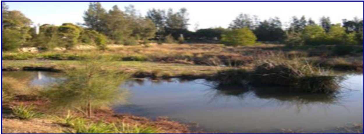
FIGURE 5; ZONE HUMIDE ARTIFICIELLE A SURFACE D'EAU LIBRE (FWS CW) POUR LE RUISSELLEMENT DES EAUX PLUVIALES DANS LE DOMAINE DE WOODCROFT PRES DE SYDNEY, NWS, AUSTRALIE (VYMAZAL, 2010).
