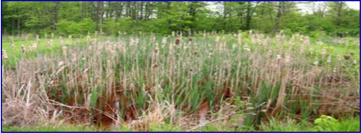
FIGURE 6: UN SYSTEME D'EPURATION DES EAUX USEES POUR LE TRAITEMENT DES EAUX DE DRAINAGE MINIERES ALCALINES A MONASTERE RUN, PENNSYLVANIE, ÉTATS-UNIS (VYMAZAL, 2010).
