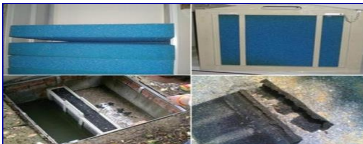
FIGURE 25: PHOTOS REPRESENTANT LE FILTRE DE FINITION, COMPOSE D'UN PORTE FILTRE ET UNE EPONGE, AVANT ET APRES UTILISATION (ROKBANE,2023).
