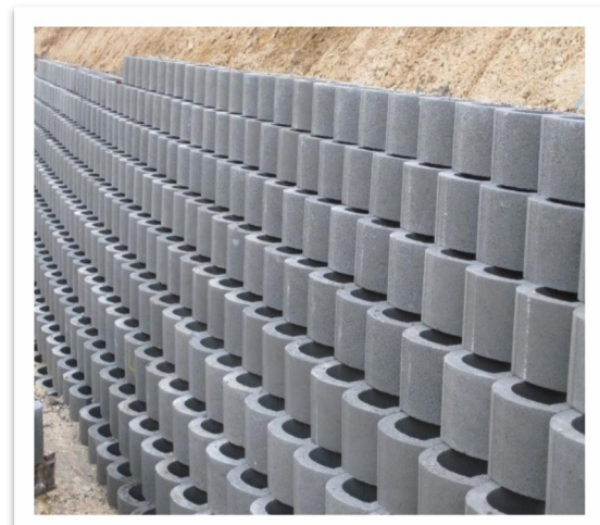
Figure I.6 Bloc empilé en béton préfabriqués.
