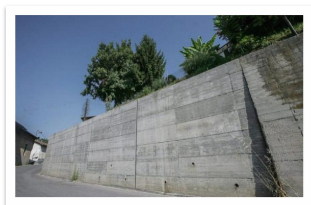
Figure I.3 Mur poids en béton.
