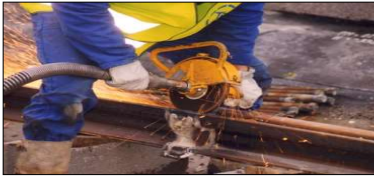
Figure II.12 : Meulage de la soudure
