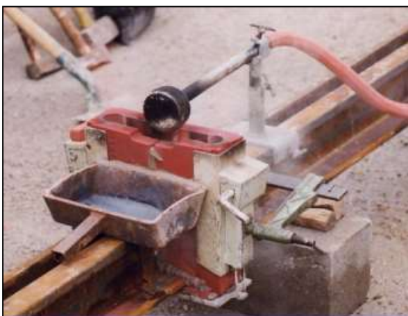
Figure II.7 : Mise en place du brûleur
