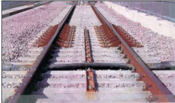
Figure II.13 Appareil de dilatation pour LGV.
