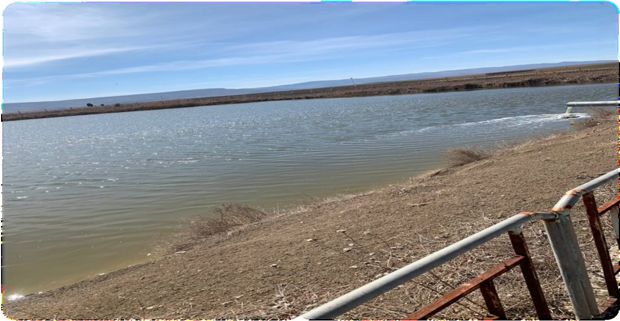
Figure 8 image de bassin de stockage
