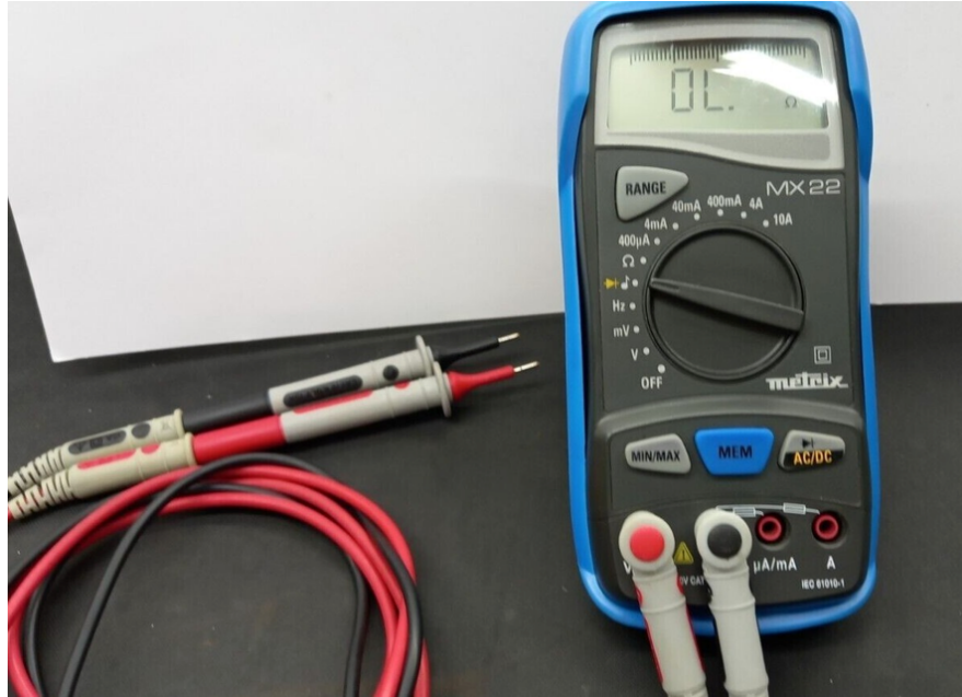
FIGURE 3.1 – Contrôle des connexions électriques du système à l'aide d'un multimètre numérique
