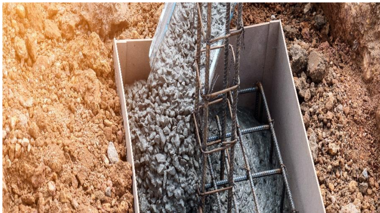
Figure VI-1 : La semelle isolée
