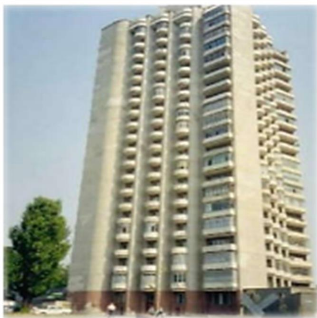
Figure 4 : Premier immeuble en béton géopolymère à Lipetsk, Russie, 1994
