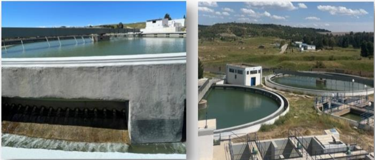
Figure III.3 : Décanteur circulaire
