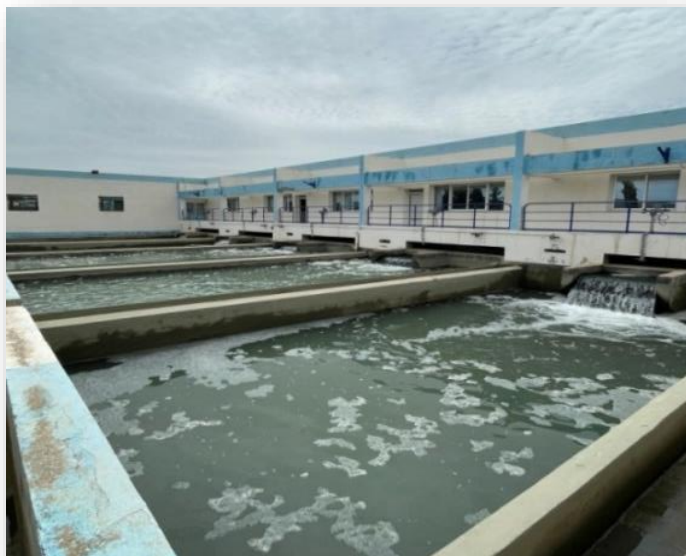
Figure III.4 : Filtre à sable.
