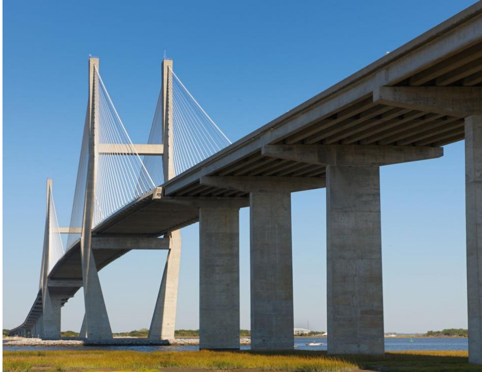
Figure I.23 : Exemple d'un ouvrage d'art en béton illustrant l'importance de l'effet d'échelle dans le génie civil [33].
