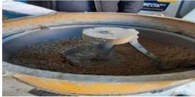
Figure III-15 Phase de malaxage mécanique du mélange
