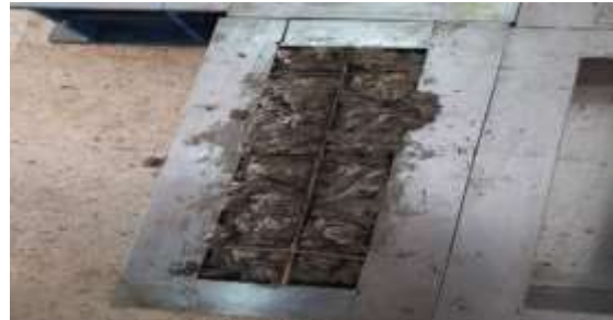
Figure III-19 Mise en place de l'armature en acier (Ferrailage)
