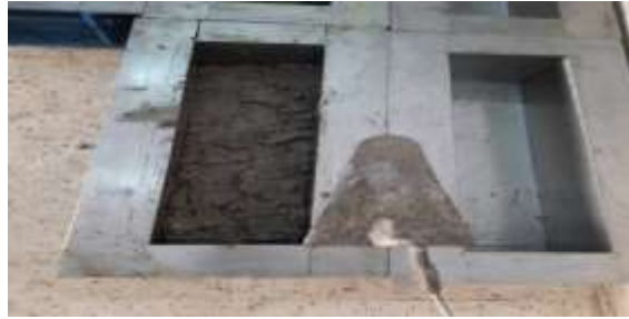
Figure III-18 Coulage de la couche d'enrobage
