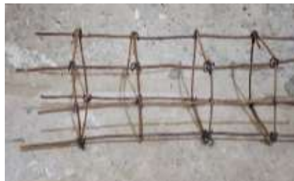
Figure III-17 Confection et ligaturage de ferrailage
