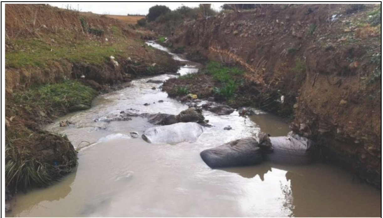
Figure 4: Ecoulement des effluents domestiques et industriels directement dans l'Oued ( Bouarissa, 2022 ).
