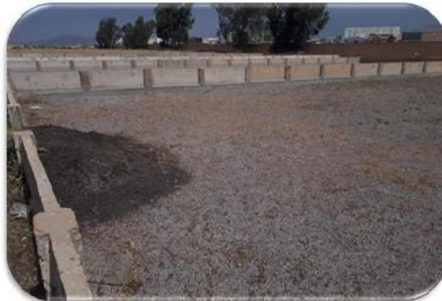
Figure III.8 : Air de stockage des boues déshydratées (STEP BBA)
