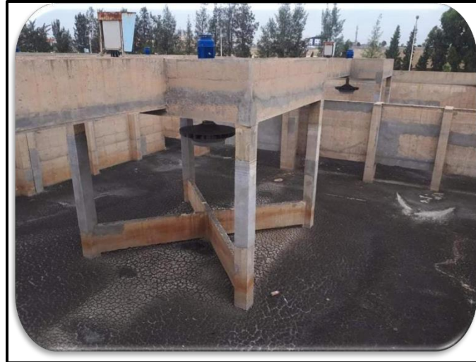
Figure III.6 : Bassin d'aération
