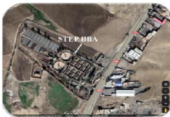
Figure III.1 Station d'épuration des eaux usées de la ville de Bordj Bou Arreridj
