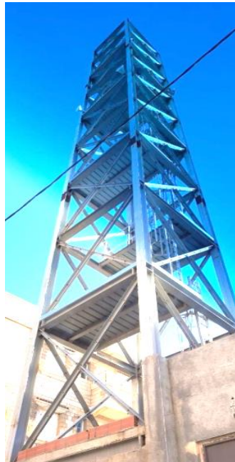
Figure 12 : Minaret en charpente métallique
