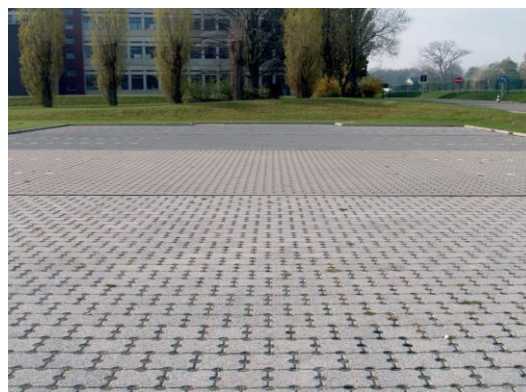
Figure 5 : Pavés en béton avec ouvertures de drainage
