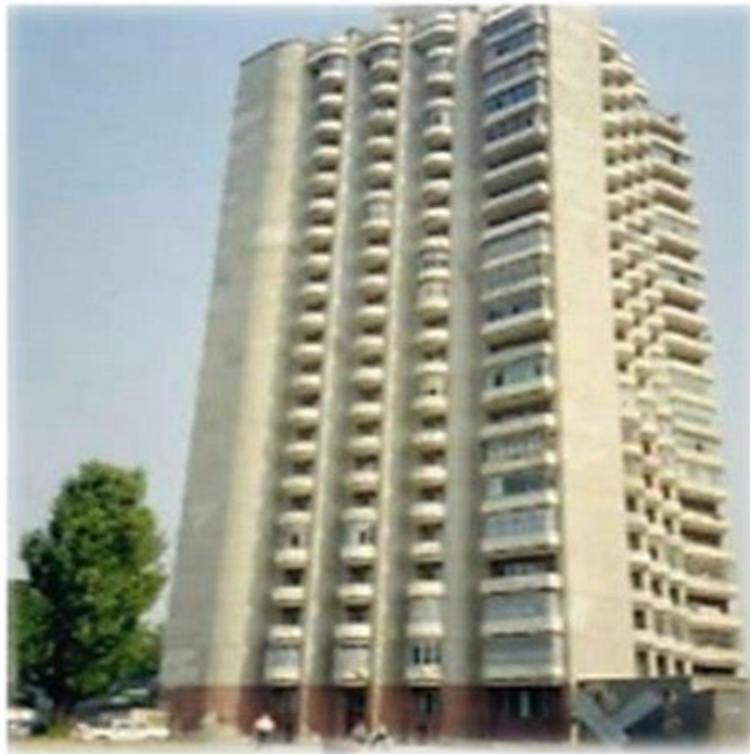
Figure 22 : Premier immeuble en béton géopolymère à Lipetsk, Russie, 1994
