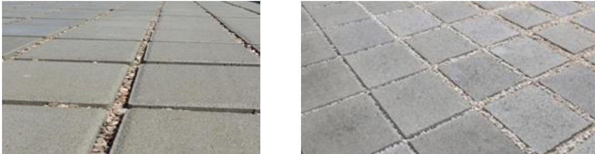
Figure 4 : Pavés en béton à joints élargis
