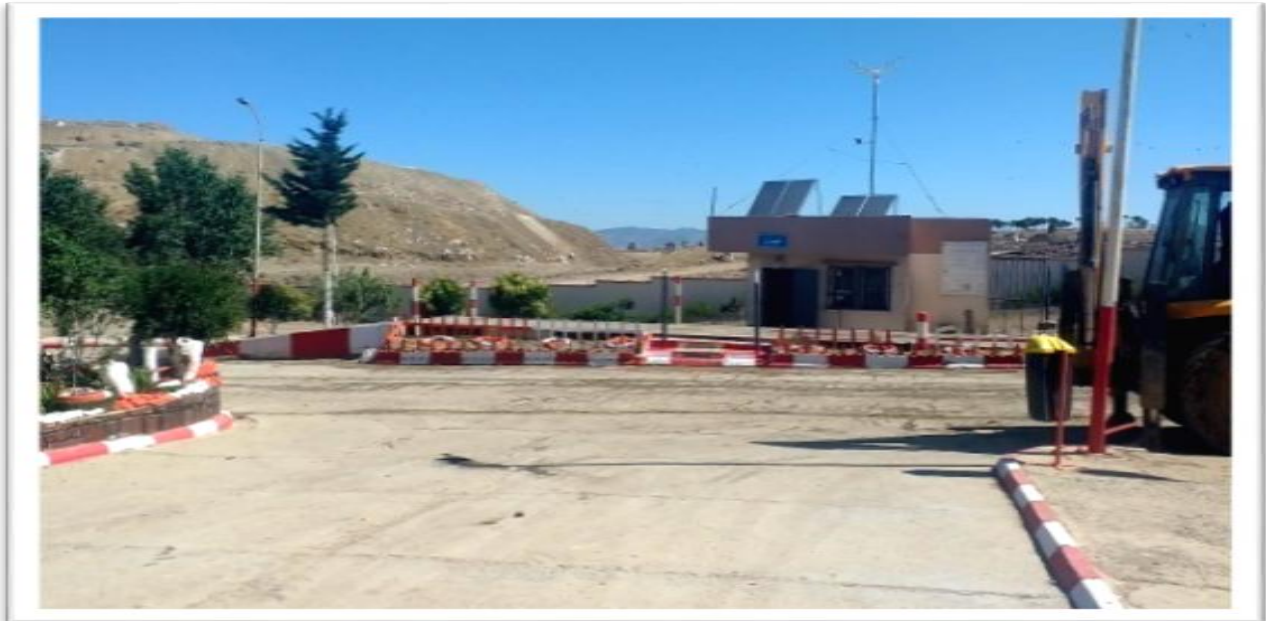
صورة لمركز الطمر التقني -برج بوعرييج-
