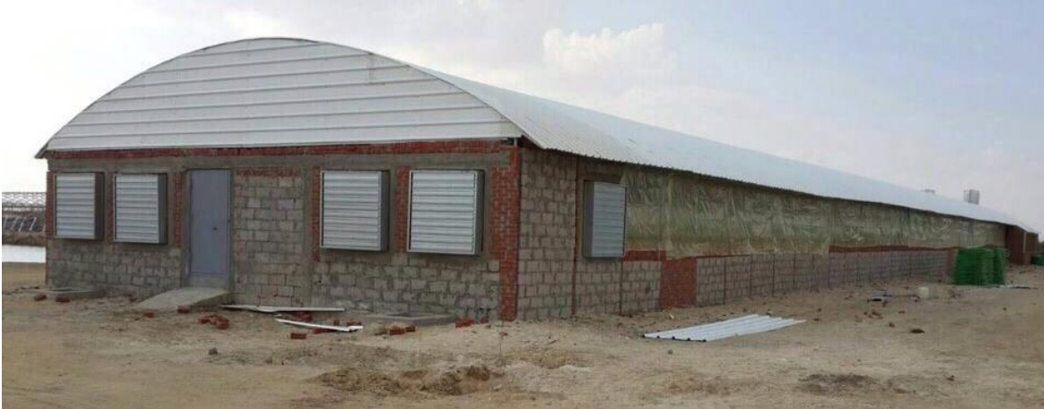
Figure I.2 : Exemple d'un bâtiment avicole obscur entièrement mécanisé [12].
