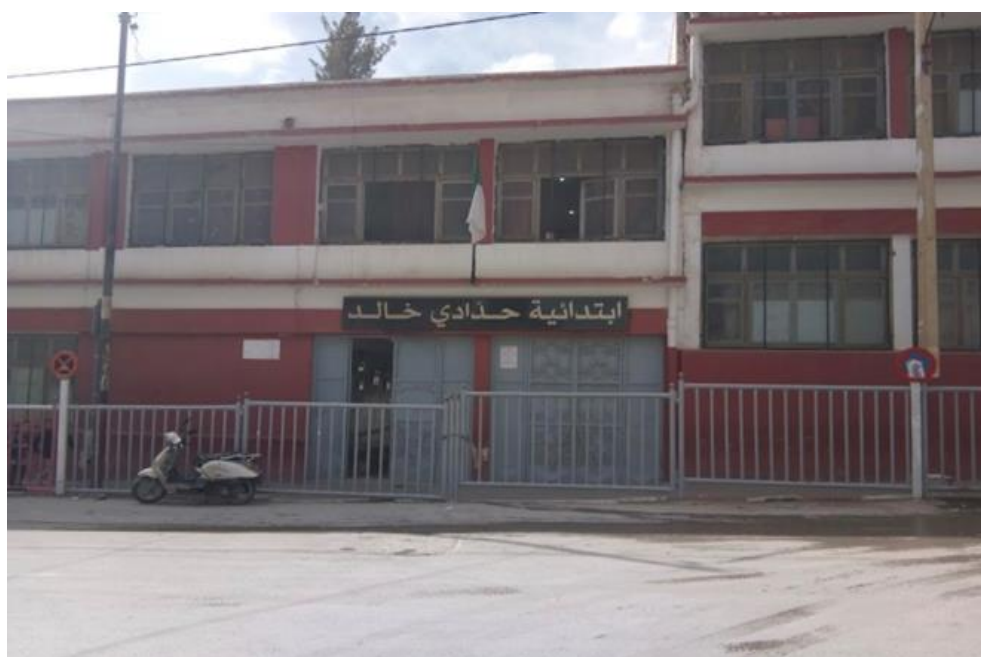
La façade de l'école Hadadi Khaled
